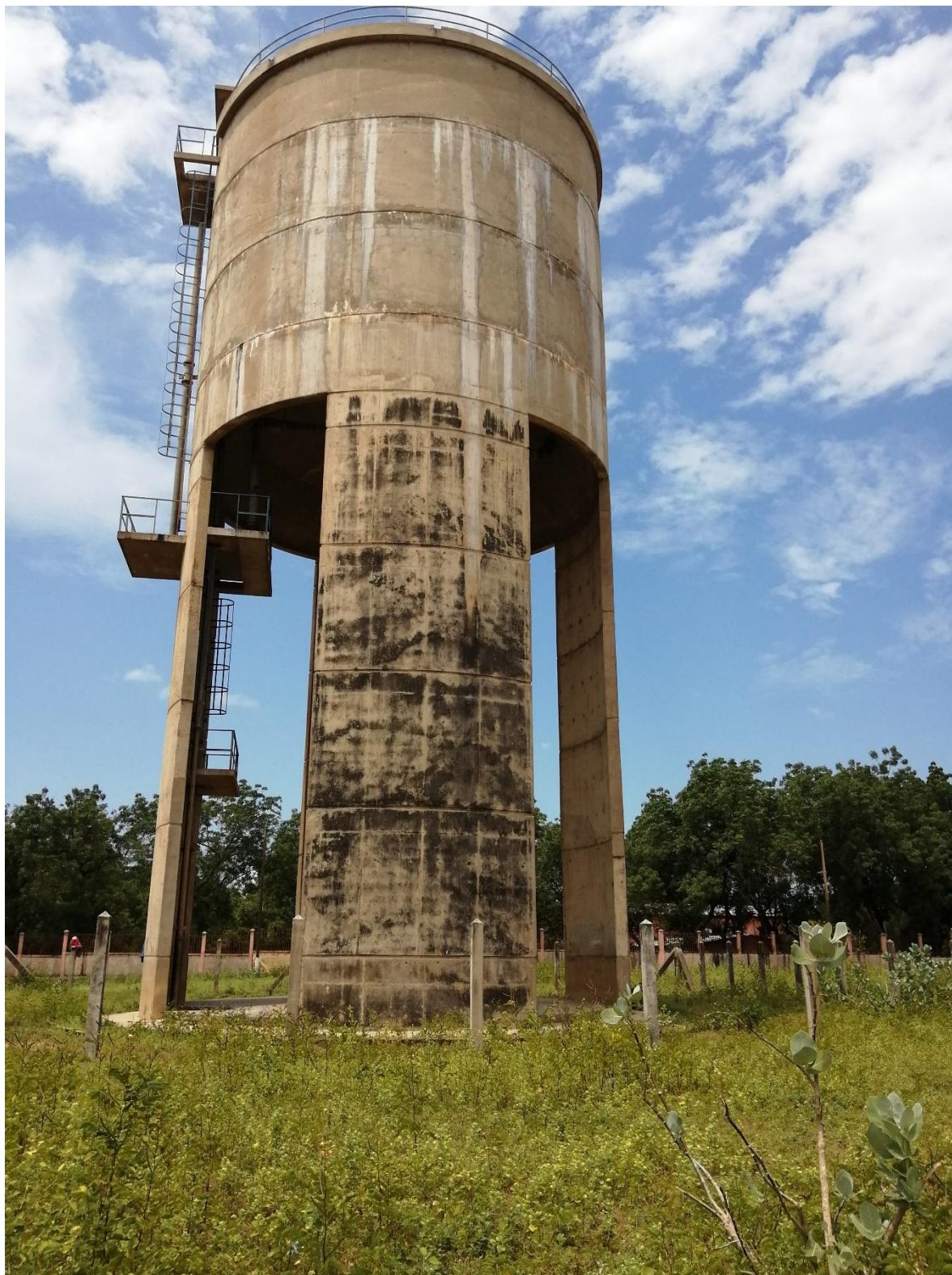
Photo 8: Château d'eau de Yagoua
