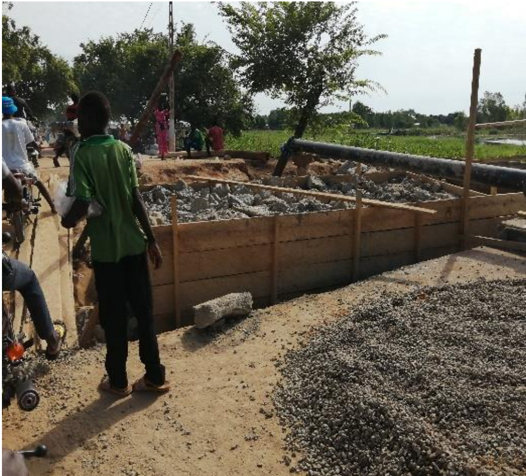
Photo 16: Travaux sur le pont endommagé de la rivière Danay. Reliant le sud au nord de la commune de Yagoua
